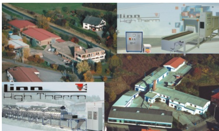
Ansicht Firmengebäude Linn High Therm in Eschenfelden und Bad Frankenhausen
